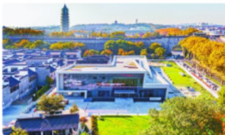
南京城墙博物馆外观初现。南京城墙保护管理中心供图
